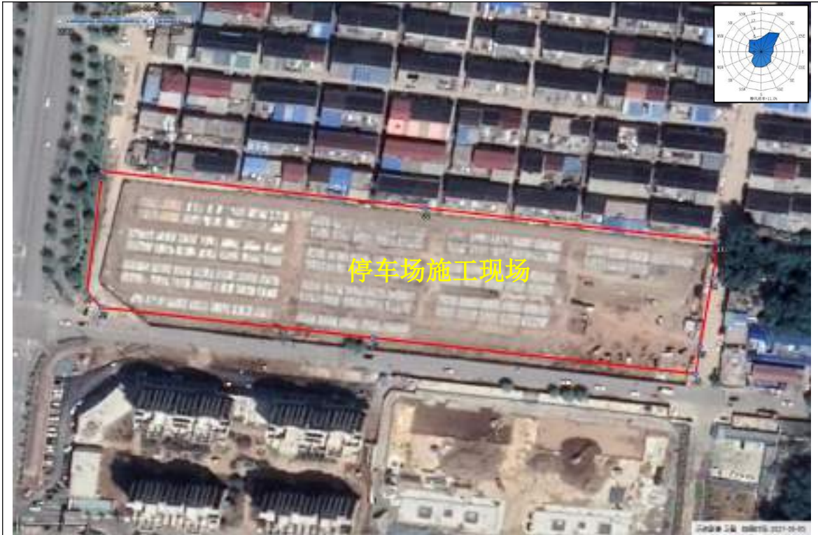
拍摄于 2021 年，地块内停车场正在施工。
