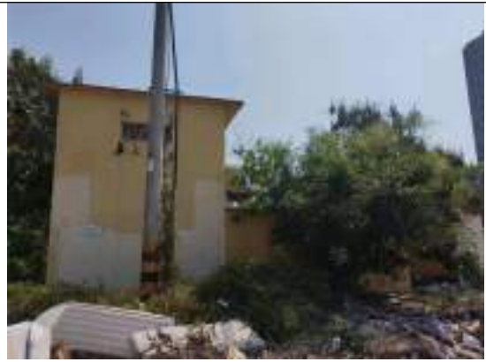
地块一西侧配电房（自西向东拍摄）
