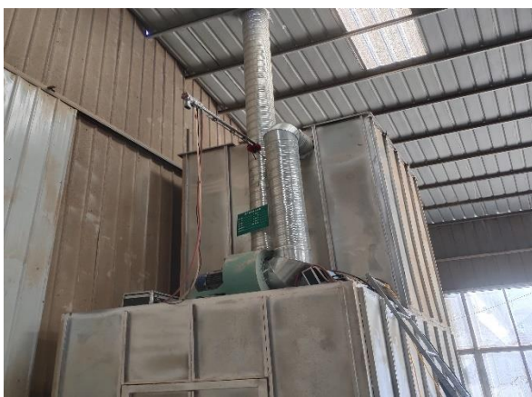
图 4-3 袋式除尘器（筛分装袋工序）
