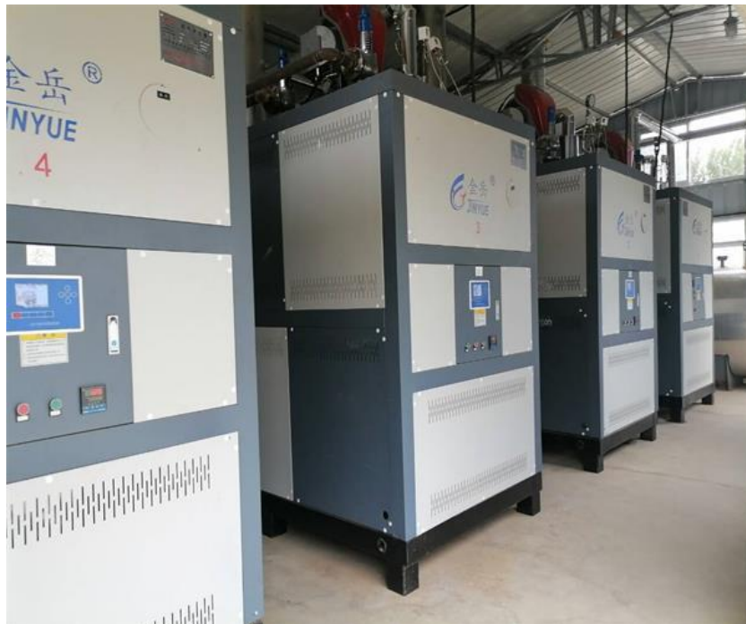
图 4-1 蒸汽发生器
