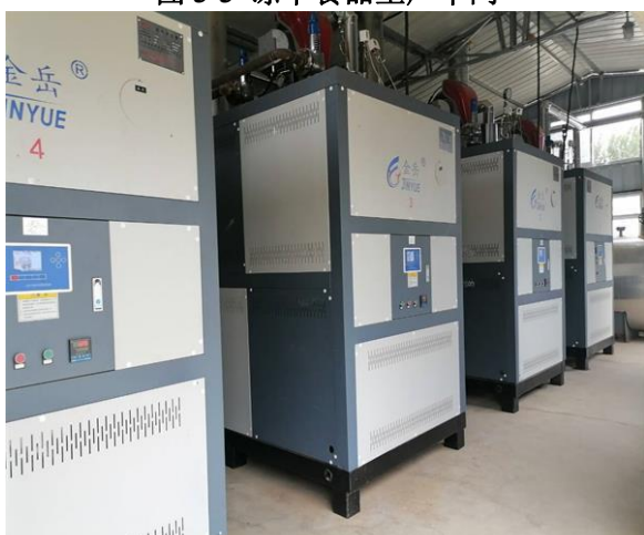
图 3-3 蒸汽发生器
