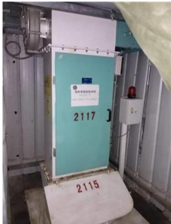
图 4-4 辅料投料工序除尘器
