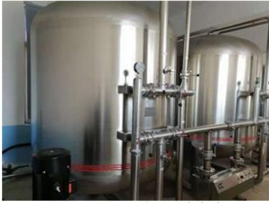
图 3-3 30T/H 水处理生产线
