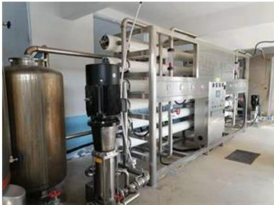
图 3-5 30T/H 水处理生产线
