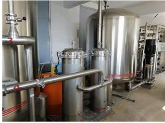
图 3-4 30T/H 水处理生产线
