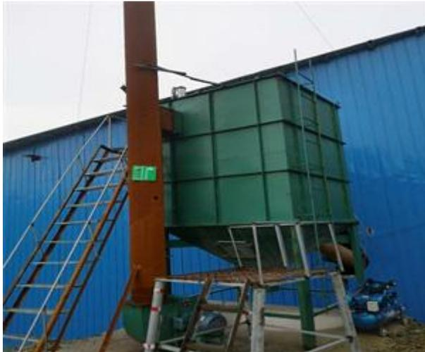
图 3-4 破碎机布袋除尘器
