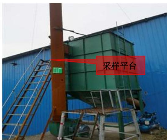
图 7-1 破碎工序废气采样平台
