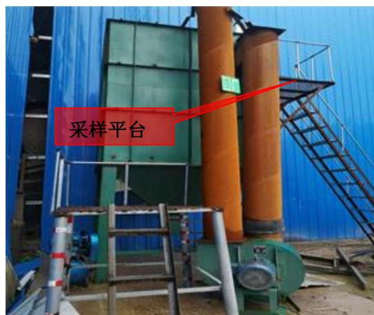
图 7-2 筛分工序废气采样平台
